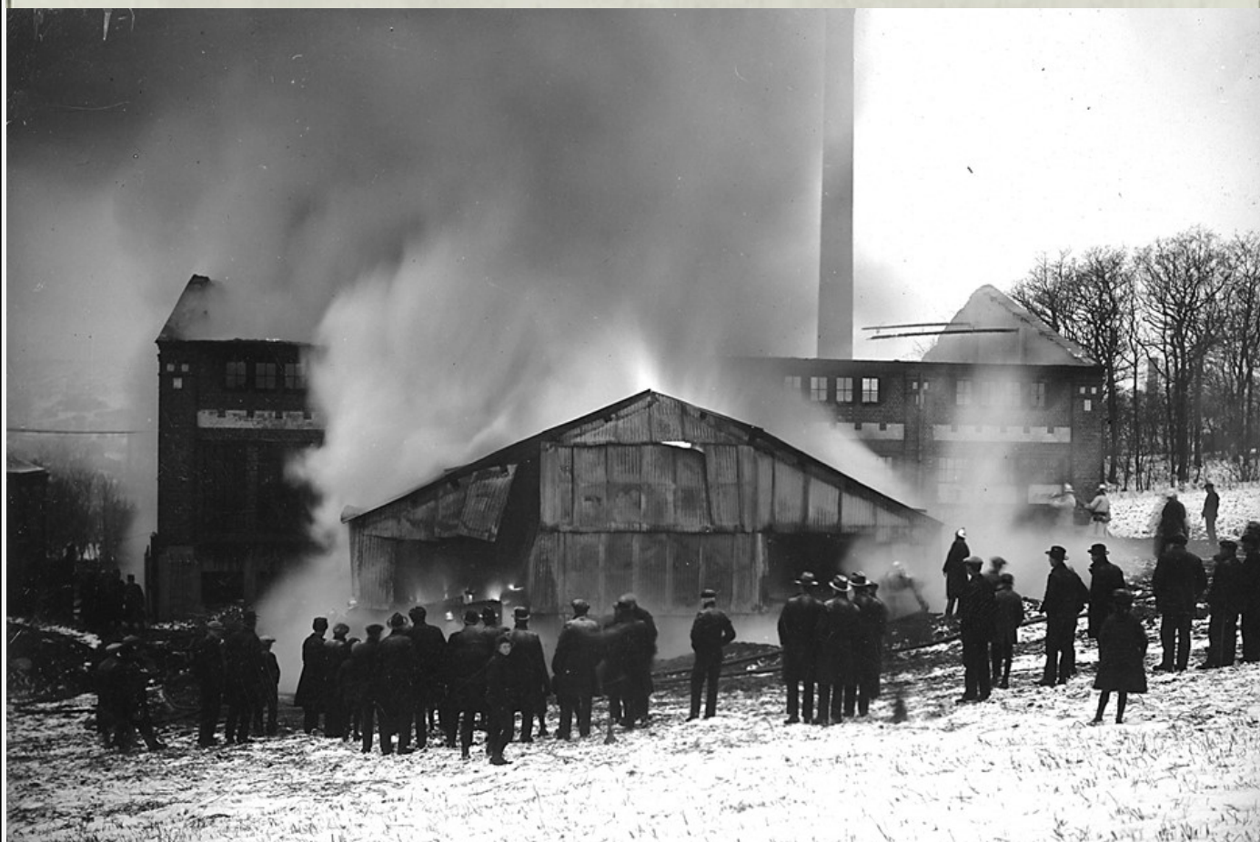
Fabriken i ljusan låga. Magasinsbyggnaden i förgrunden.
