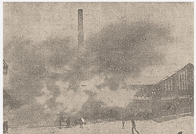
Den brinnande byggnaden.
