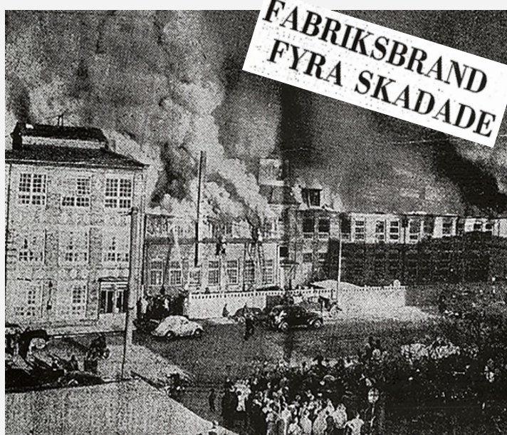
Rökutvecklingen var enorm och brandkåren fick snabbt ge upp försöken att släcka från insidan.
