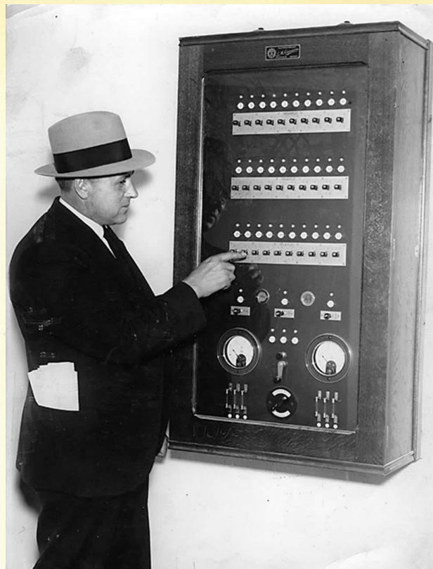
Kontroll av centralapparat
