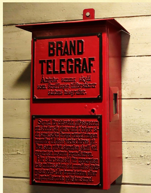
De första brandskåpen var anordnade så att man skulle krossa en glasruta och ta ut den hängande nyckeln, med vilken skåpdörren öppnades, varefter man hade att sakta dra i ett snöre, innan apparatens löpverk sattes i gång.
