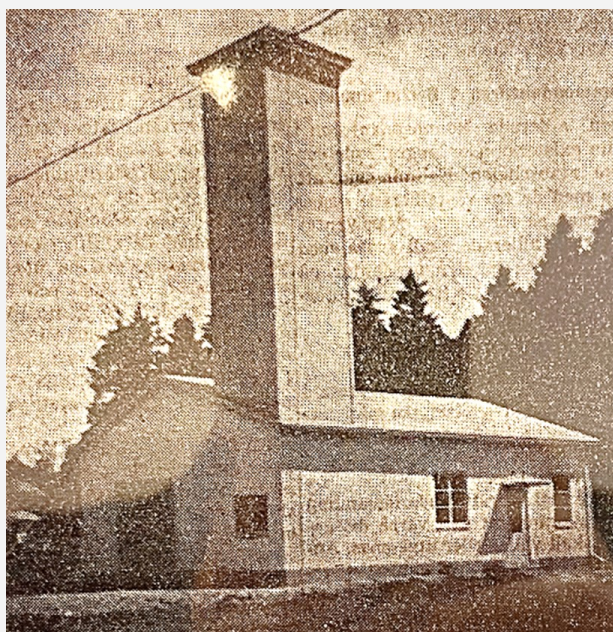
Den nya brandstationen 1948
