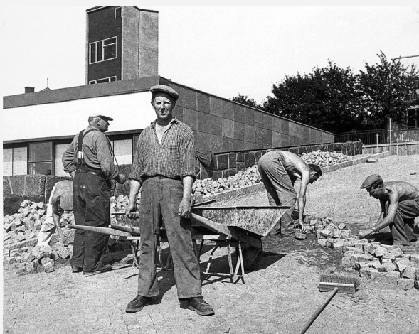
Här pågår arbetet med att stensätta Edsgatan utanför den nya brandstationen. Lagg märke till den fina stenvallen intill trottoaren.
