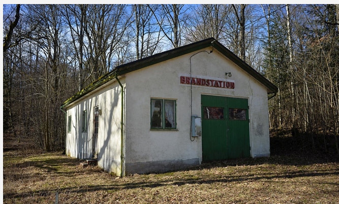
Brandstationen i Östad
