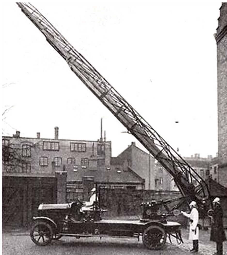
Fig. 74. Brandkårens 28-meters motorstege. Inköpt 1921.
