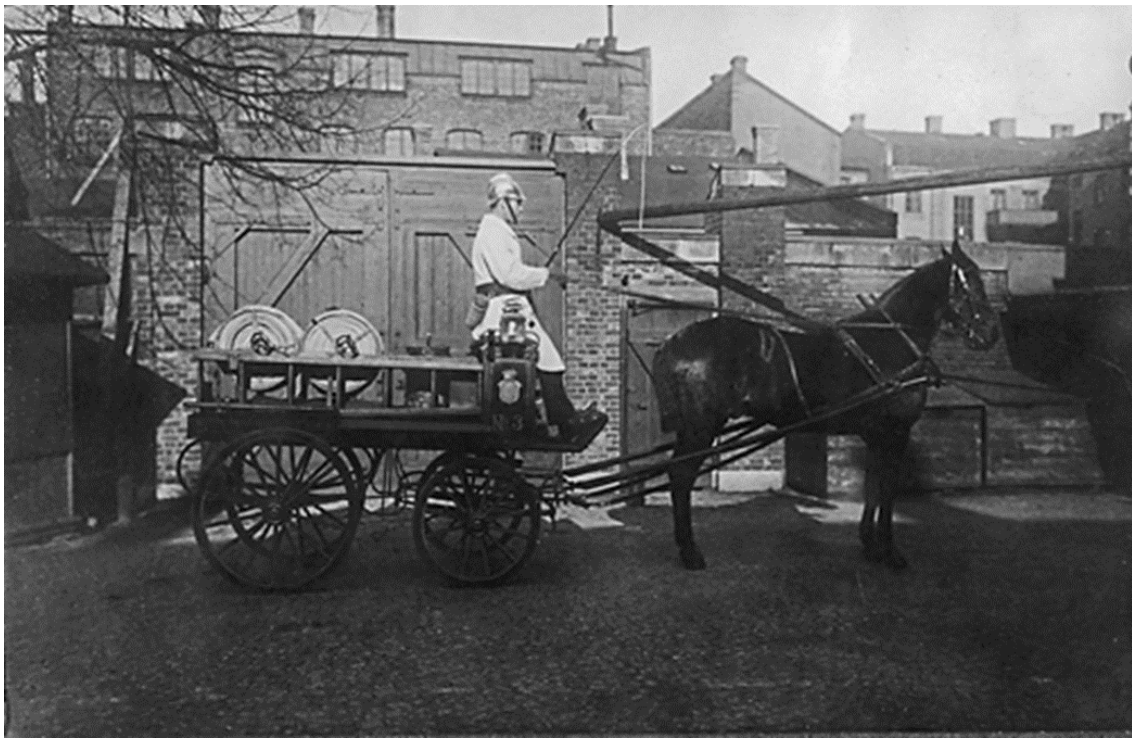
Fig. 69. Den s. k. soteldsvagnen Anskaffad i början av 1890-talet
