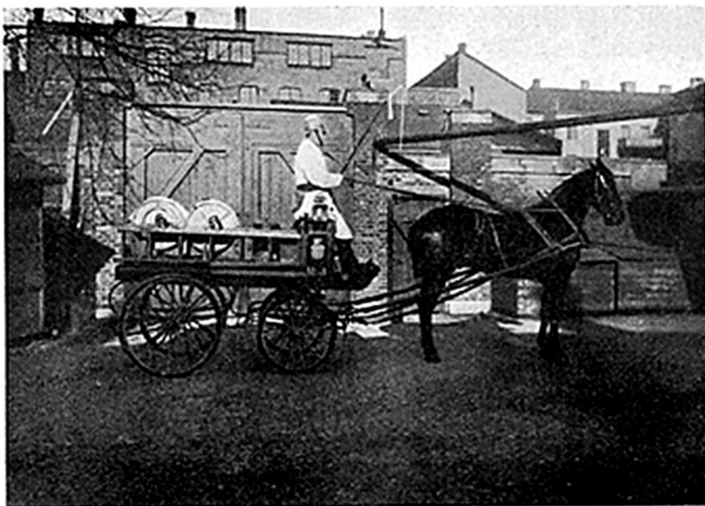
Fig. 69. Den s. k. soteldsvagnen. Anskaffad i början av 1890-talet.
