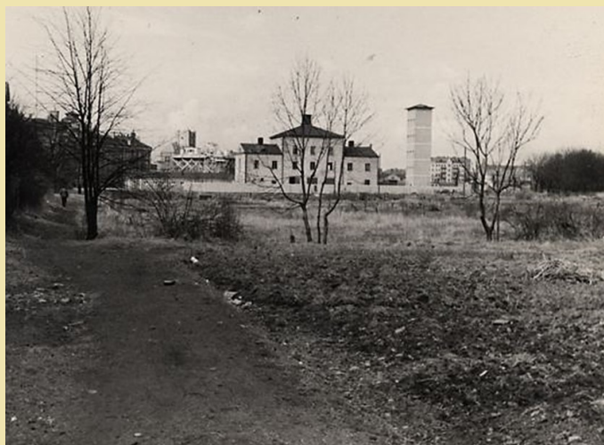
GhmR:121:27 Carlotta Hedens Brandstation vid Bohusgatan från söder.
